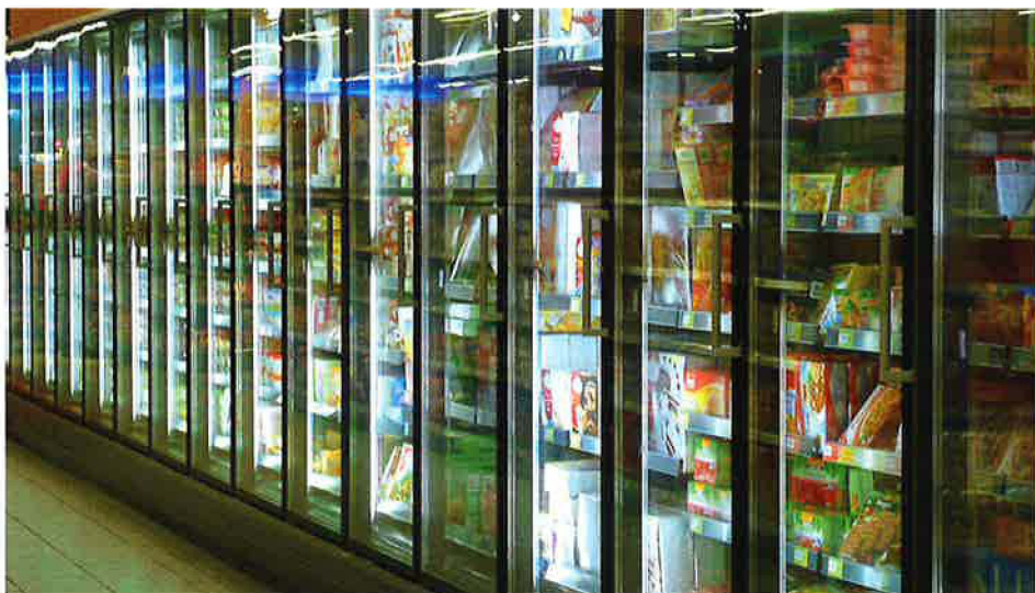
Die Verglasung von Kühlregalen mit Türen verbessert die Energieeffizienz, auch weil die Kälteanlage kleiner ausgelegt sein kann.
