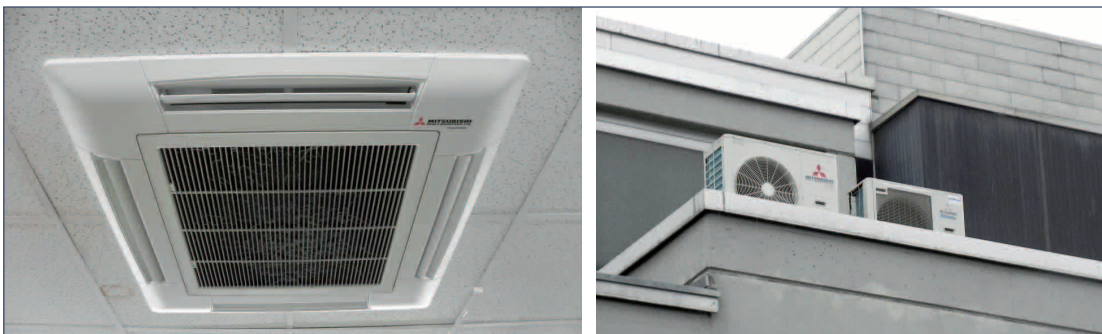
Abbildung 31. Typisches Klima-Splitgerät zum Nachrüsten
