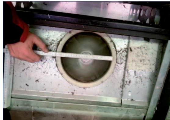
Abbildung 35. Einbau im Kühlmöbel 80
