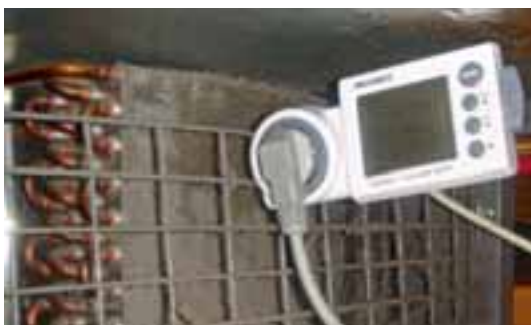
Abb. 49. Verschmutzung Verflüssiger
