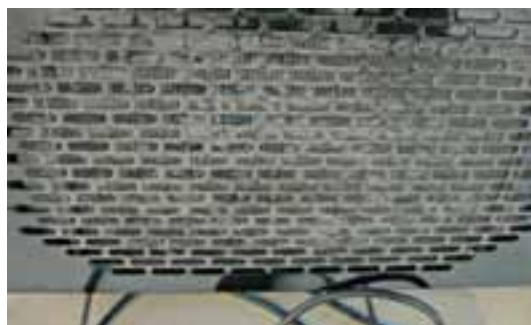
Abb. 50. Verschmutzung Verflüssiger 2
