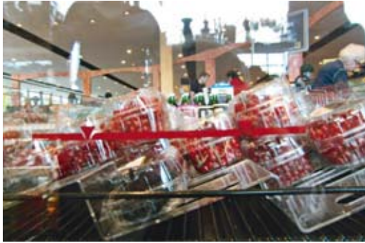
Abb. 42. Füllhöhe nicht eingehalten
