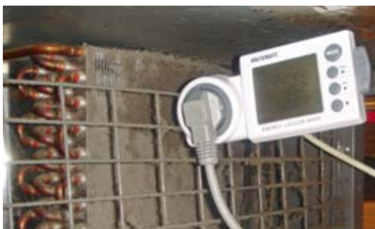
Abb. 49. Verschmutzung Verflüssiger
