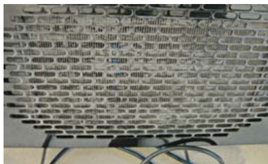
Abb. 50. Verschmutzung Verflüssiger 2
