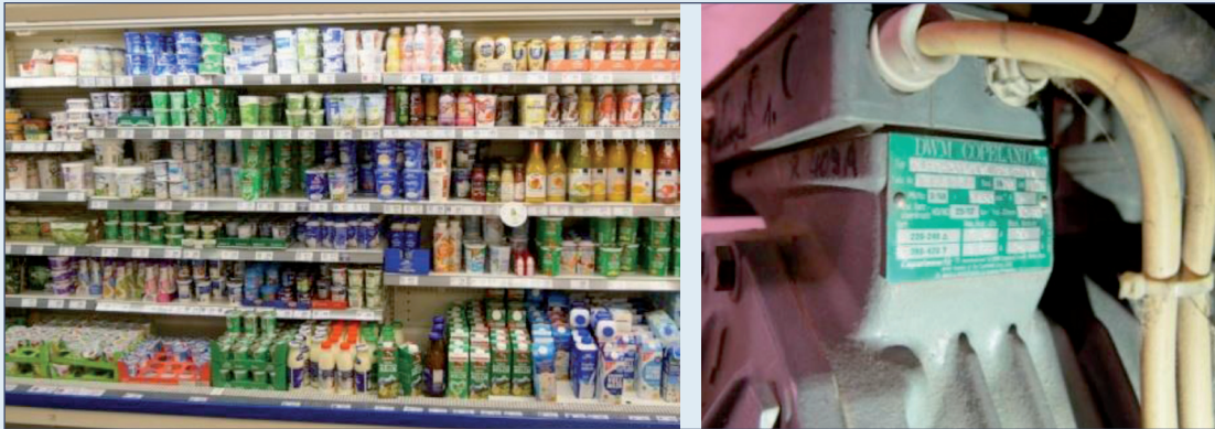
Abbildung 5. Kühlregal „Aindling I“ mit Einzelanlage aus 1979
