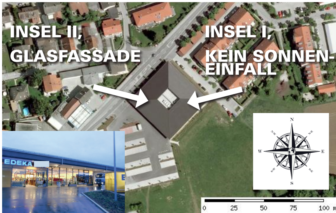
Abb. 57. Glasfassade mit Süd-West-Ausrichtung
