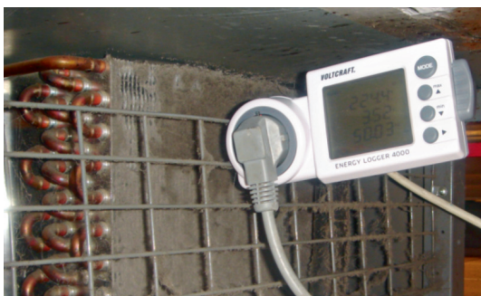
Abb. 49. Verschmutzung Verflüssiger
