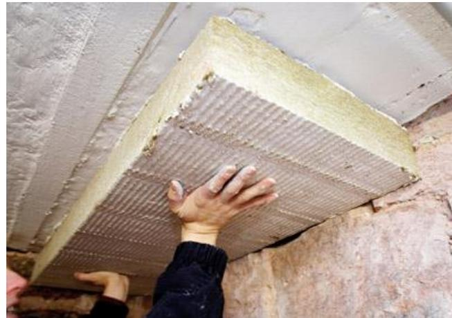
Faustregel: Eine Verdoppelung der Dämmstärke führt zu einer Halbierung des U-Wertes
