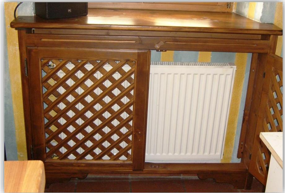
Wenig durchlässige Lüftungselemente belasten die Lüftungsleistung
