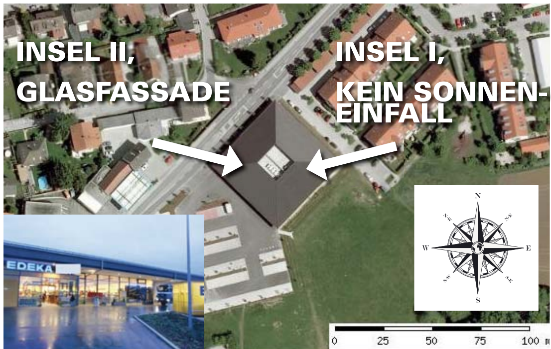
Abb. 57. Glasfassade mit Süd-West-Ausrichtung
