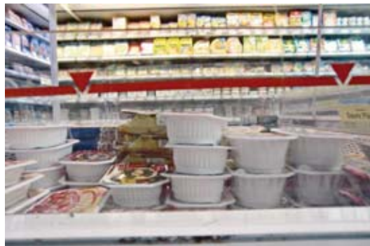
Abb. 43. Max. Füllhöhe eingehalten
