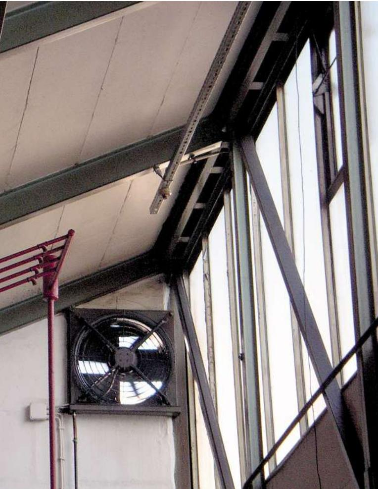
**Die Heizung wärmte die nicht isolierte Decke statt die Halle und der Ventilator daneben pustete die erzeugte Wärme sofort nach draußen. Damit gingen 70% der Energie verloren.**
