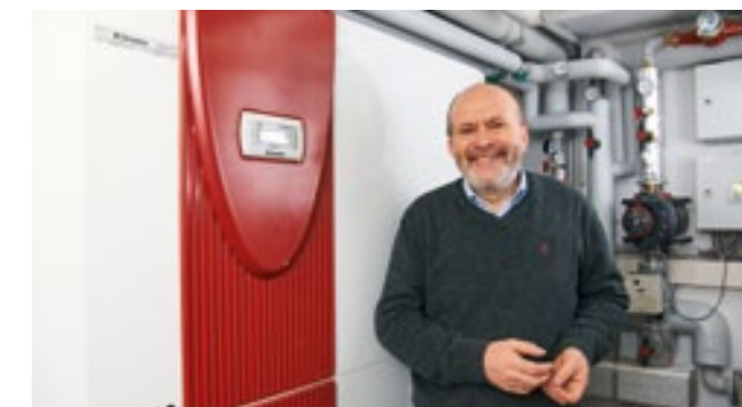
Die Wärmepumpe – Herzstück von Jerzy Timms Energiemanagement-System
