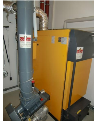
Abbildung 19. Pelletskessel
