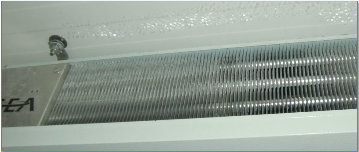
Abbildung 45. Ungünstige Eisbildung an den Verdampferlamellen
