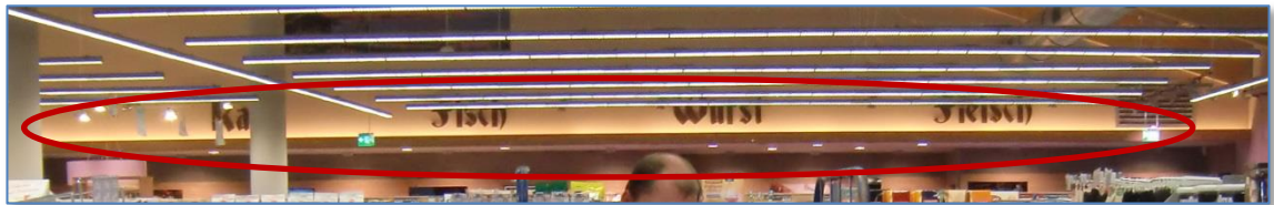
Abbildung 40. Indirekte Beleuchtung - Bedienbereich
