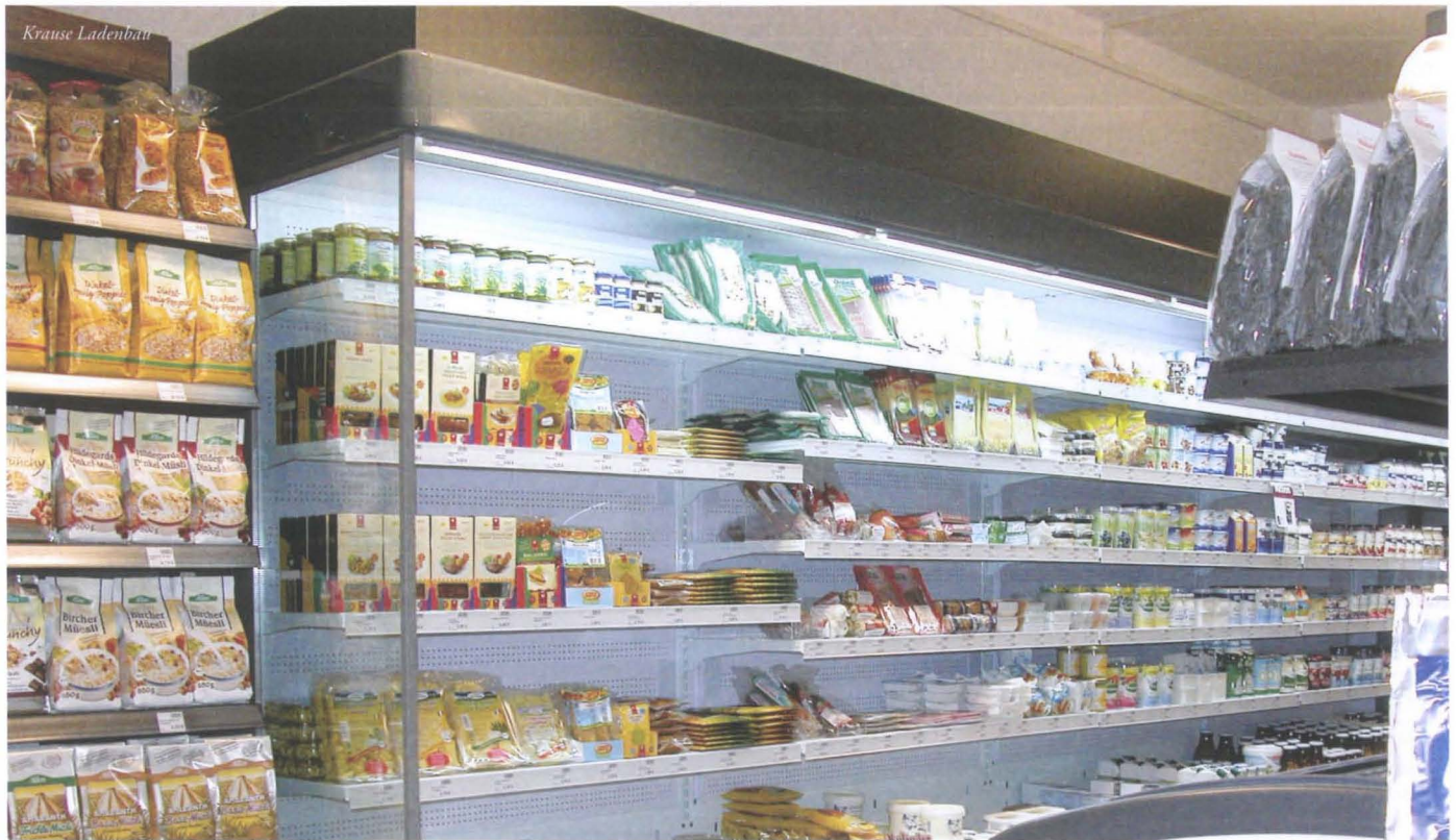
Kühlmöbel haben einen hohen Strombedarf. Durch Türen an Kühlmöbeln kann dieser gesenkt werden.
