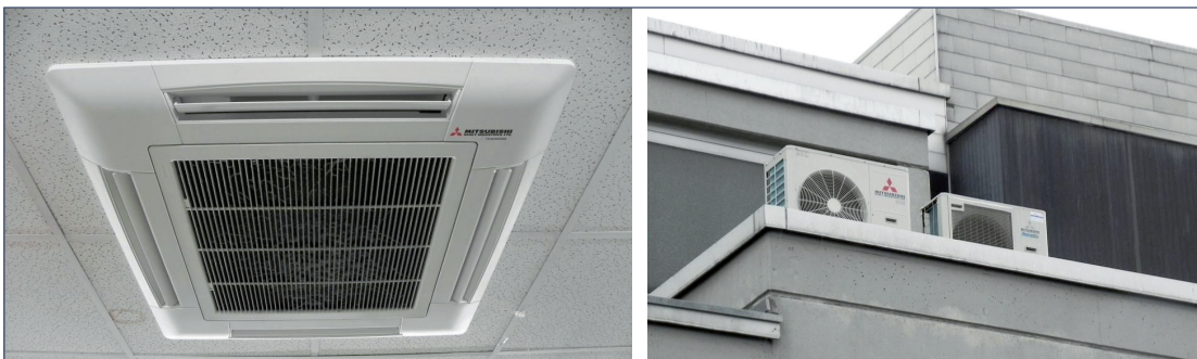
Abbildung 31. Typisches Klima-Splitgerät zum Nachrüsten
